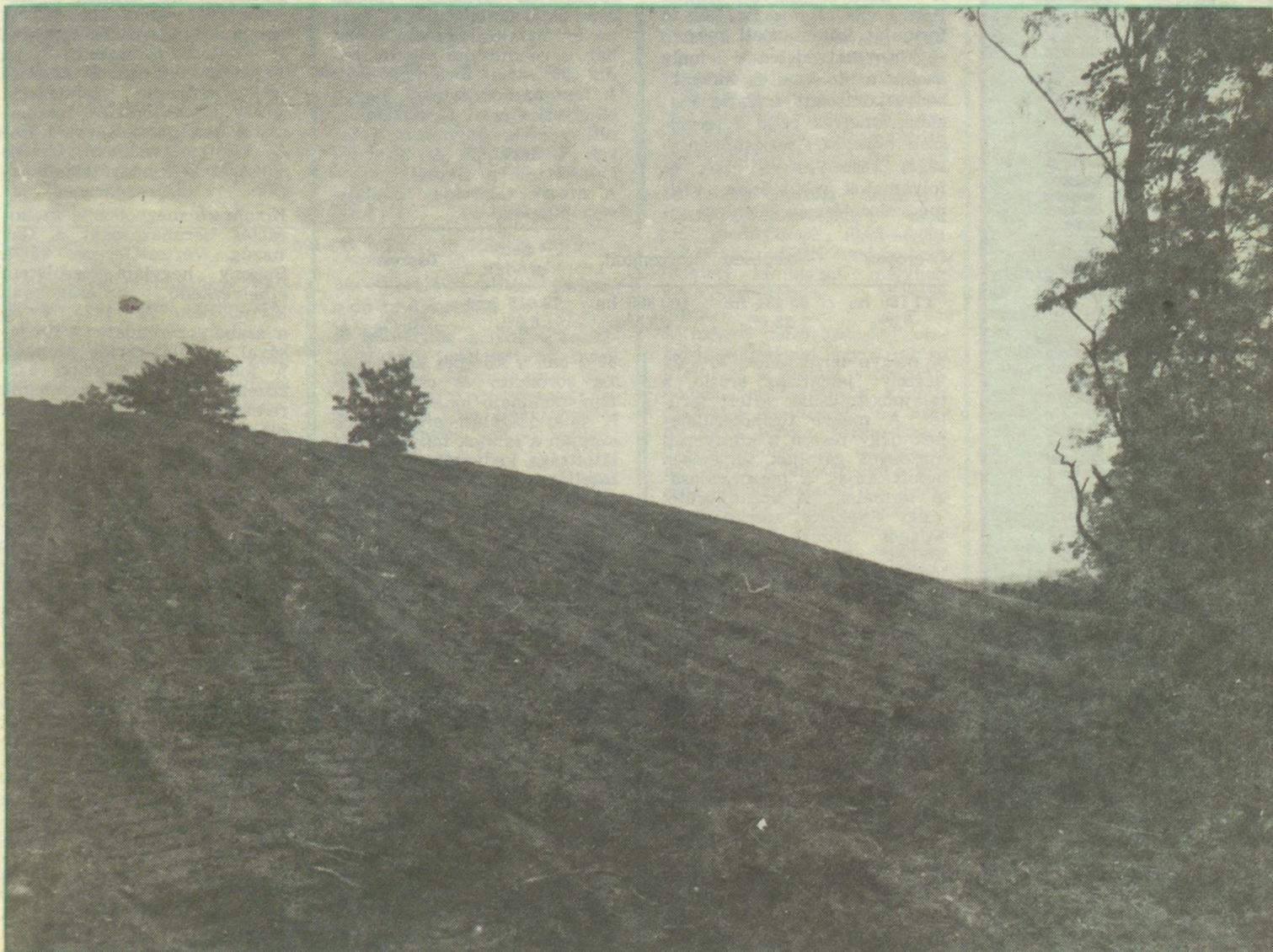
Meddőhányó rézsürendezése, teraszolás előtt az Oroszlányi Szénbányák területén
