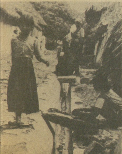
Nyitott csatorna egy indiai faluban, Guruvarajapalayamban
