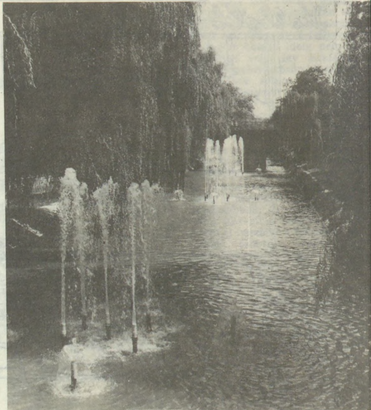
A gyulai Előviz-csatorna levegőztetése. (Schermann Akos felvételei)
