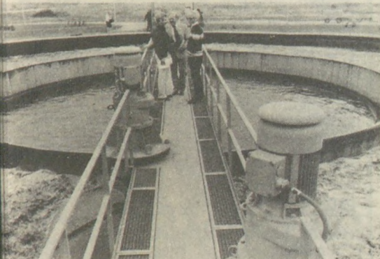
Vízisztítók rendszere sokat javít majd a Balaton vízminőségén. Képünkön a keszthelyi szennyvíztisztító telep levegőztető medencéje. (Eifert János felvétele)
