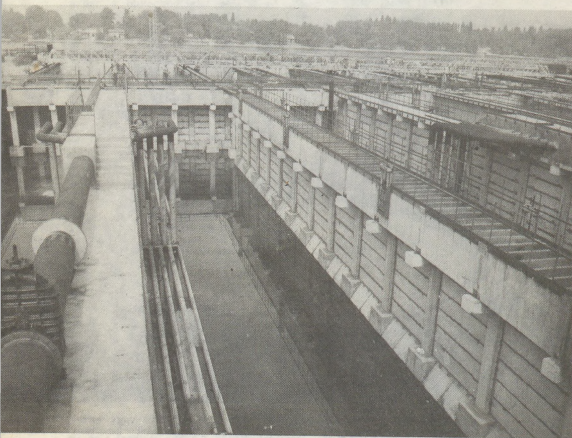
Az épülő biológiai tisztító a Fővárosi Csatornázási Művek Észak-pesti Szennyvíztisztító Művében
