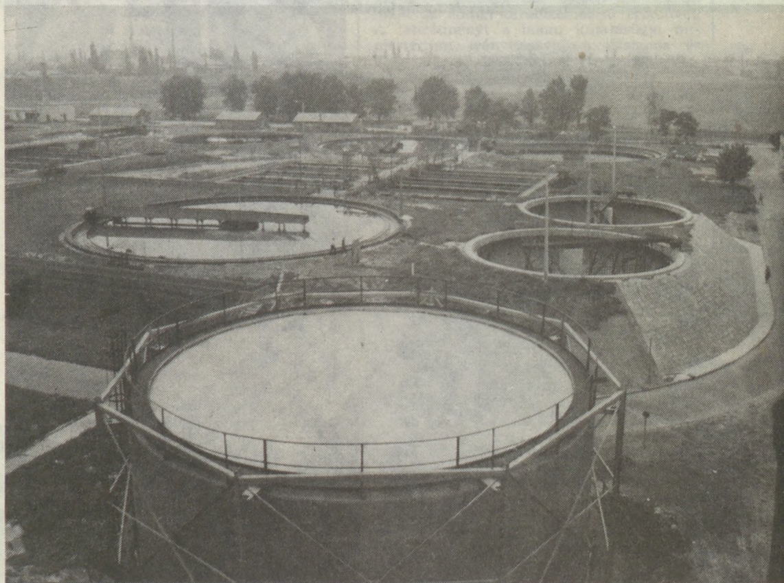
Biogáz-tartály (a kép előterében) a Fővárosi Csatornázási Művek Dél-pesti Szennyvíztisztító telepén
