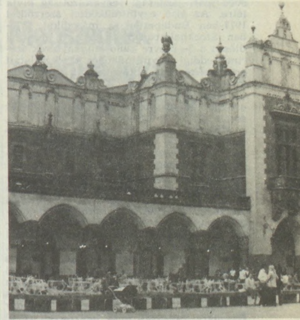
A krakkói gótika csipkeit elmállasztja a kohókból jövő kén-dioxid
