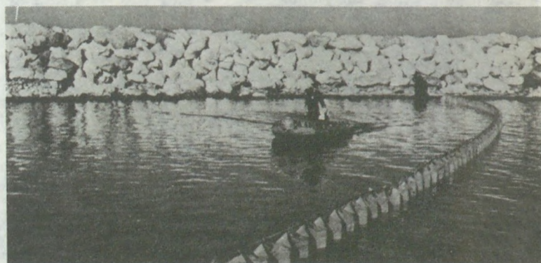
Úszógát az olajszenyezés elkerülésére
