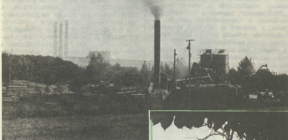
Nem csak a DCM! KÉV-betonkeverő-telep a cementgyár mellett
