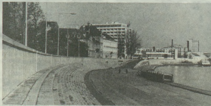
A város egyik büszkesége: a tovább épülő árvízvédelmi partfal
