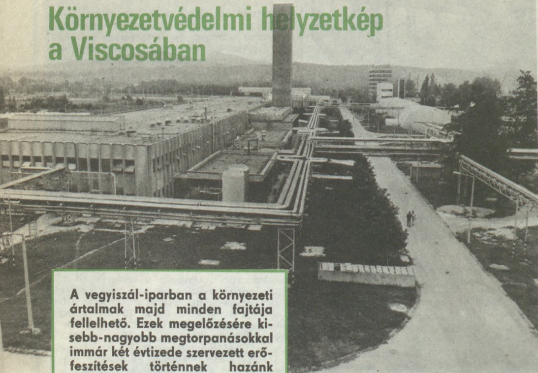
A közelmúltban készült el ez az előtérben látható 105 méter magas kémény, amely a tisztított füstgázokat emeli a magasba
