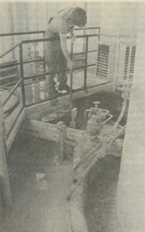
Levegőbefúvással működő, zsírfelúszatós, ÉLGÉP tervezte vitzisztító berendezés zsírcsúszató aknája a Tejjari Vállalat szombathelyi üzemében
