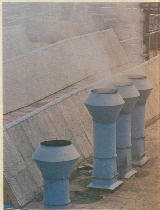
A Fagazdasági Kombinát szombathelyi farostlemezgárának zsákos szűrőve! összekötött ciklontornyaiából már csak kevés por távozik
