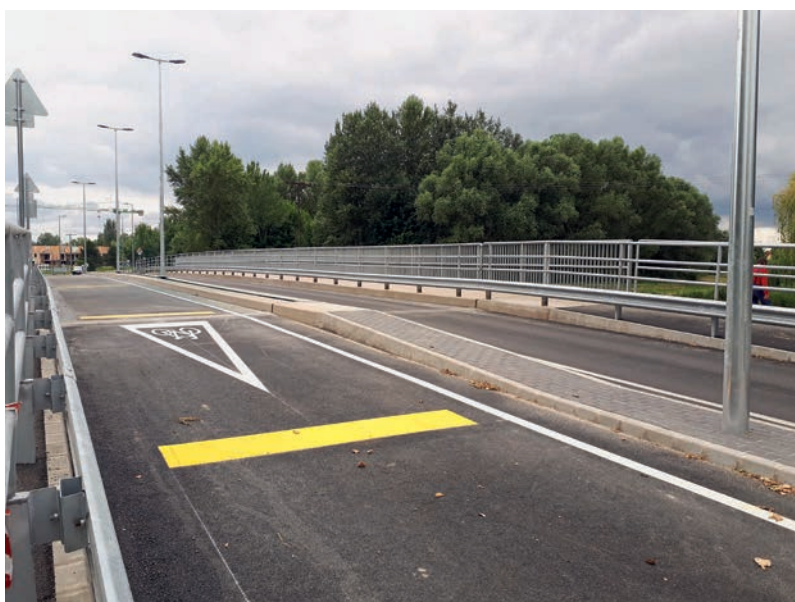
1. ÁBRA. A két ütemben megépült mosonmagyaróvári Lajta-híd 2019-ben [3]
