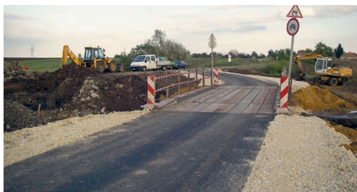
13. ÁBRA. A Csinse-patakon épített építési provizórium a közút terelőútjában [32]
