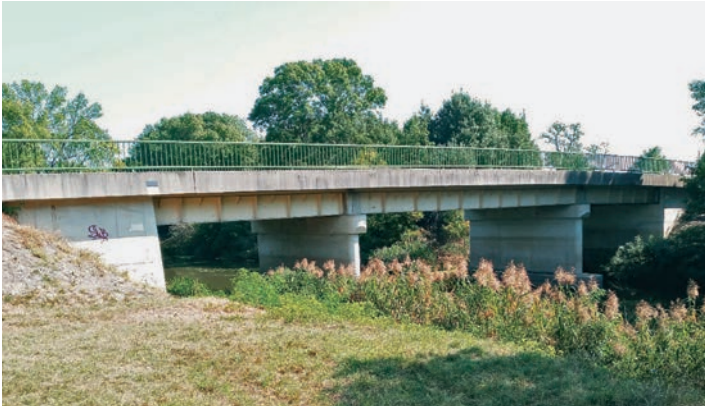
9. ÁBRA. REM-500 főtartóból épült túrkevei Hortobágy-Berettyó-híd [26]
