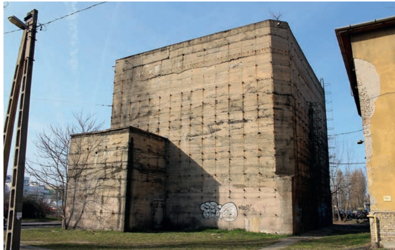
8. ÁBRA. A MÁV egykori vezetési pontja Budapesten, a ferencvárosi vasúti pályaudvar mellett. A BGS típusú négyzetes, földfelszíni „kocka” óvóhely jelenleg kiállítóhely (A szerző felvétele)
