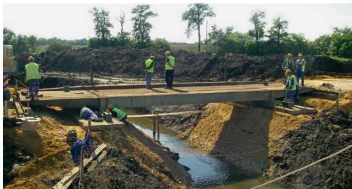
12. ÁBRA. 8,5 m-es SBG-66 provizórium 3,0 m-es rámpás elemekkel építés közben [32]
