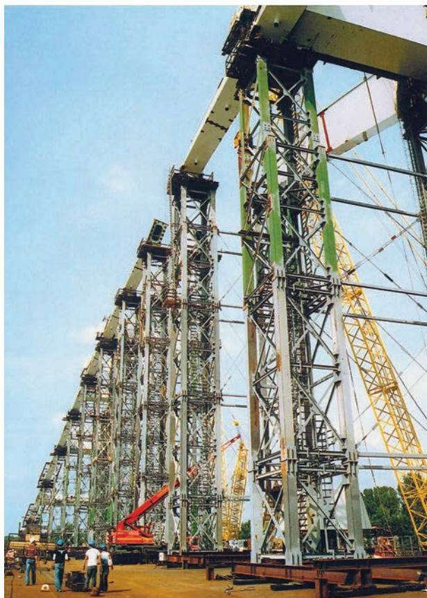
14. ÁBRA. SBG-66 gerendákból gyártott segédszerkezet [33]
