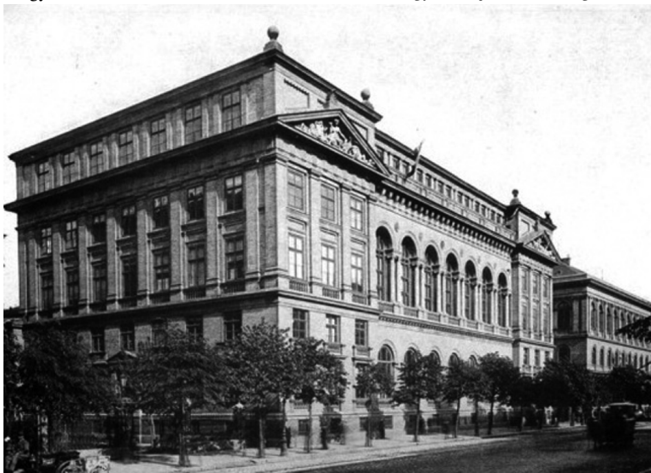
Az ELTE Múzeum körút 4. sz. épülete, a „4a”, a II. világháború előtti fényképen. Az 1950–60-as években ez volt az összes geológiai tanszék helye
