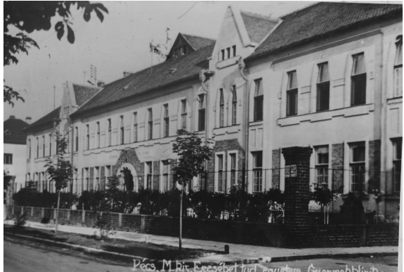
10. kép – A Gyermekklinika épülete
