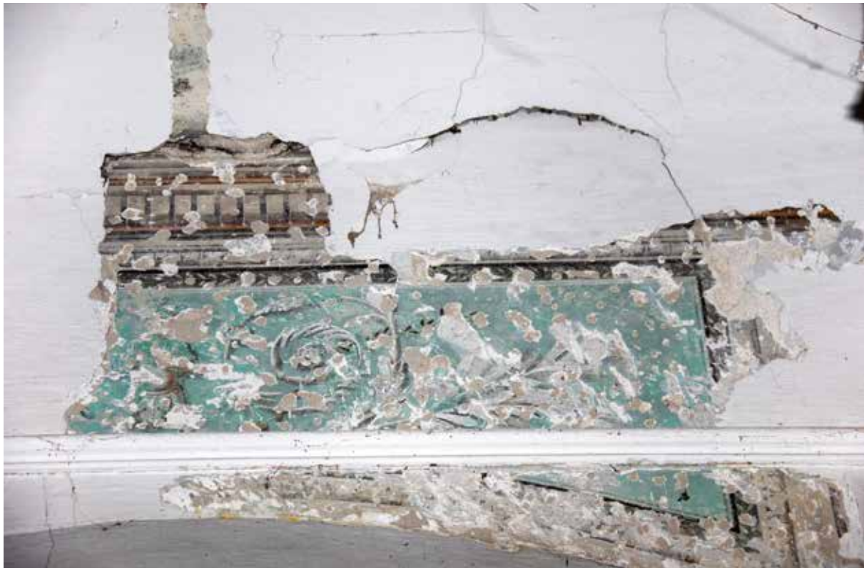
4. kép. Az emeleti 2.04 szoba feltárt második periódusú díszítőfestésének részlete, 2022. szeptember (fotó: Bíró László) Fig. 4. Detail from a second period ornamental painting in room No. 2.04 situated on the top floor, taken in September 2022 (photo by László Bíró)
