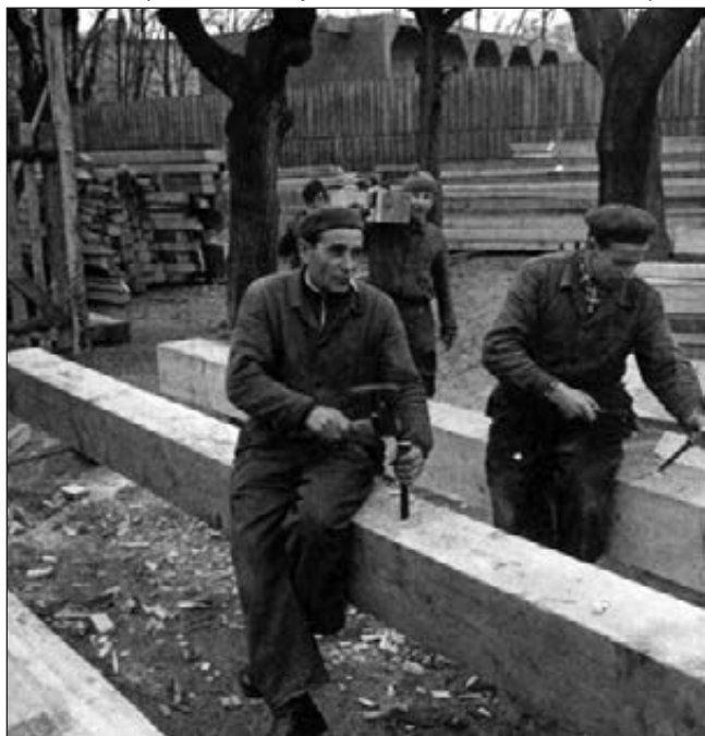
A Kertmozi építkezésén dolgozó ácsok. Fotó: Péterfay
