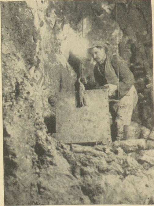
Rakodás a fenéken. Jól látható a veder forgását és hintázását megakadályozó kifeszített vékony vashuzal és a huzalt átfogó villa. A szerző felvétele
