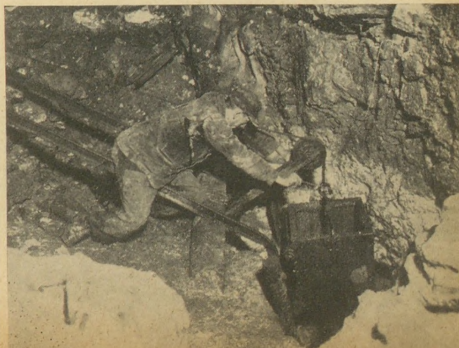
A buktató-csiga felemelésével a szerző bebuktatja a vedret az álfenekébe süllyesztett aknába. A képen látható, hogy a drótkötél a bal hónalj alatt fekszik s a csiga visszacsapódását megakadályozó dróthurkot jobbkézszel húzza a foggantyúra. A szerző felvétele
