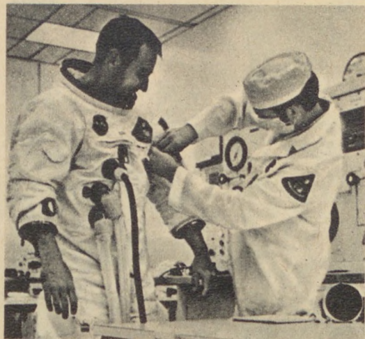
A szkafander ellenőrzése. Az űrhajón jobboldalt elől látható az élettani paramétereket közvetítő kábel, az oxigén-csatlakozó, és a nyomásadagoló levegőrendszer csatlakozó csöve
