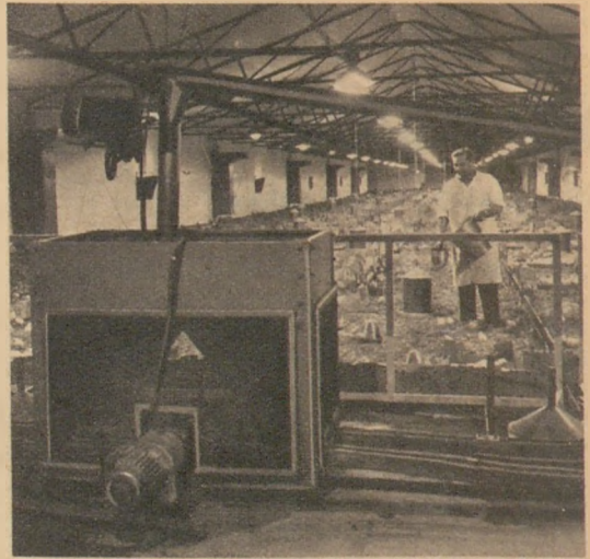
A halászi „Rákóczi” Tsz „csirkegyárának” berendezése az 1964-es Kievi Világkiállításon nagy sikert aratott. A Mosonmagyaróvári Gépgyár által készített berendezés teljesen automatizálja az etetést, az itatást, a fűtést és a szellőzést. Minden munkát elektromos vezérlőberendezés irányít. A fény mennyiségét is pontosan szabályozzák. Egy négyzetméterre mindössze 1 Lux fényt juttatnak, így a csibék jobban fejlődnek (MTI Fotó — Bajkó József felv.)
