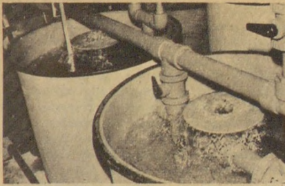
A műanyagból készült tengervíz tisztító tartályokban a szűrt vízhez levegőt is kevernek, hogy az öntisztulás tökéletes legyen
