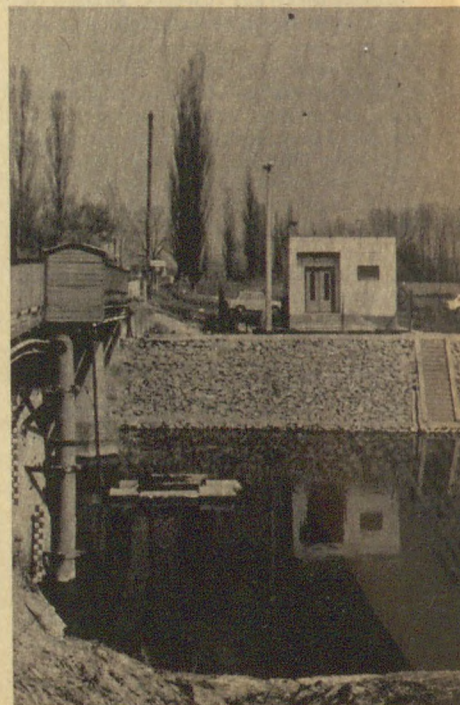
A sajópuszpöki monitorállomás, melynek automatikusan működő mérőberendezése telexen továbbítja a mérési adatokat a vízminőségi adatbankba
