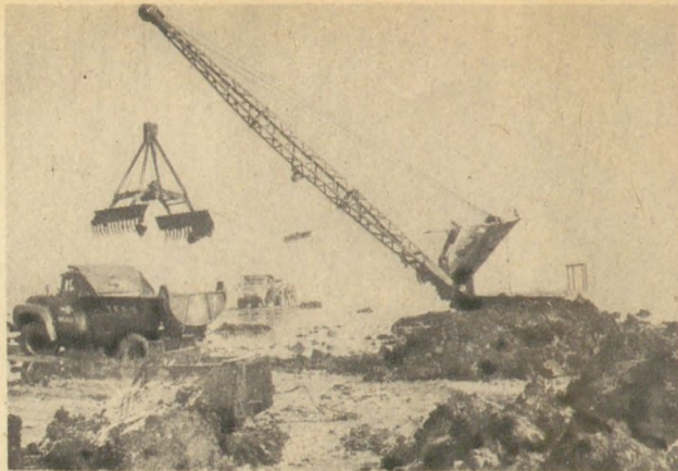
Pakuraszennyeződést eltávolító mocsárkotró — munka közben (A Szolnoki VIZIG fotói)
