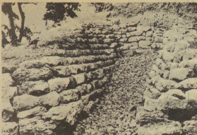
Sziklakert — építés közben. A nagy kövek közt már ott látható a kőzsalékból kialakított drénréteg. (Rácz István felvétele)
