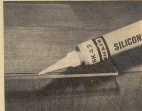
A szilikonkaucsuk-ragasztót legfeljebb hurkapálca vastagságban nyomjuk az üveg szélére
