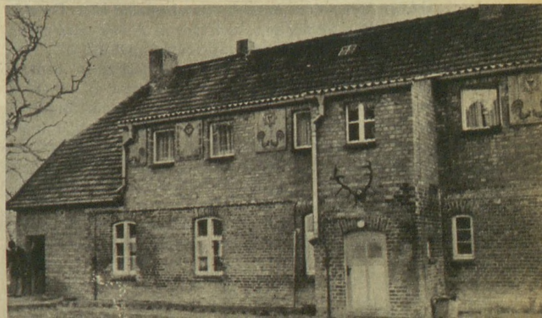
A Mezőgazdasági Tudományos Akadémia Tájkutatói és Természetvédelmi Intézete szakképző iskolájának egyik épületszárnya Waren-Müritzhofban. A népi díszítésekkel tarkított pirostéglás falak mögött korszerű tanműhely és a tanfolyamhallgatók emeleti vendégszobái nyertek elhelyezést. (A szerző felvételei)
