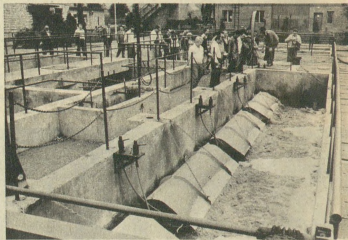
A balatonfüredi korszerű szennyvíztisztító telep oxigén-dúsító mecencéinek működését mutatják be a környezetvédelmi sajtó képviselőinek. (Nagy Iván felvételei)
