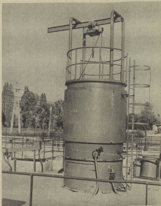
A Balatonfüredi Szennyvíztisztító Telepen a szennyvízben lévő foszfort ezzel a Foszfex-berendezéssel távolítják el. Ez a berendezés vas-szulfát és alumínium-szulfát adagolására egyaránt alkalmas
