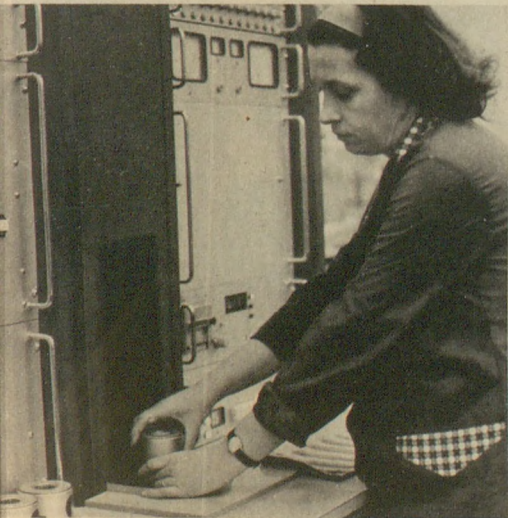
Az elektrofilterek munkáját is számítógéppel ellenőrzik a hejőcsabai cementgyárban
