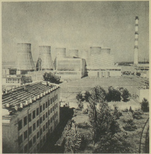
A Don partjára települt új voronyezi városrészben épült fel az 1000 megawattos teljesítményű atomerőmű. A szovjet szakemberek által kidolgozott új technológia szerint a felhevült hűtővíz energiáját lakások fűtésére használják
