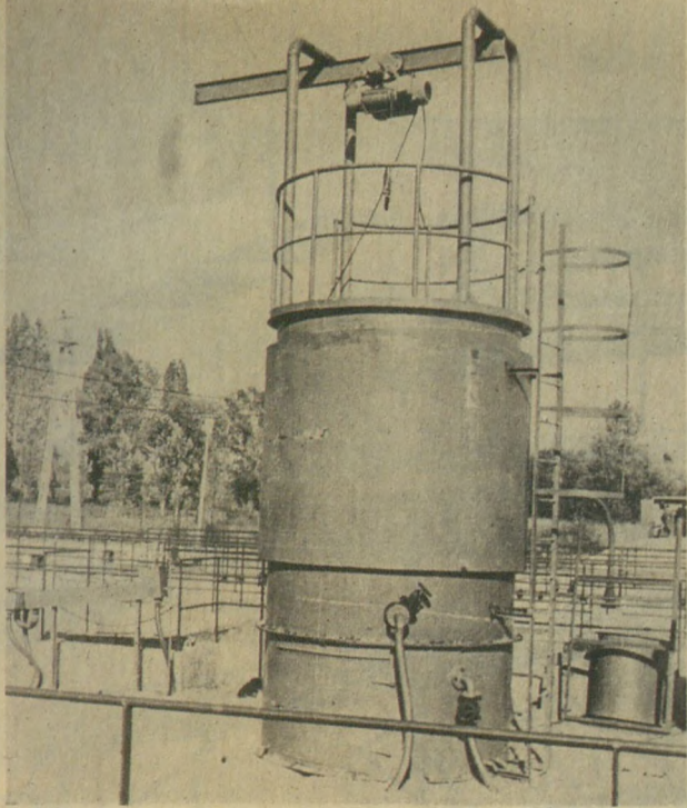
Balatonfüreden a szennyvízben levő foszfort ezzel a Foszfórex-berendezéssel távolítják el. (Dr. Dobolyi Elemér felvétele)
