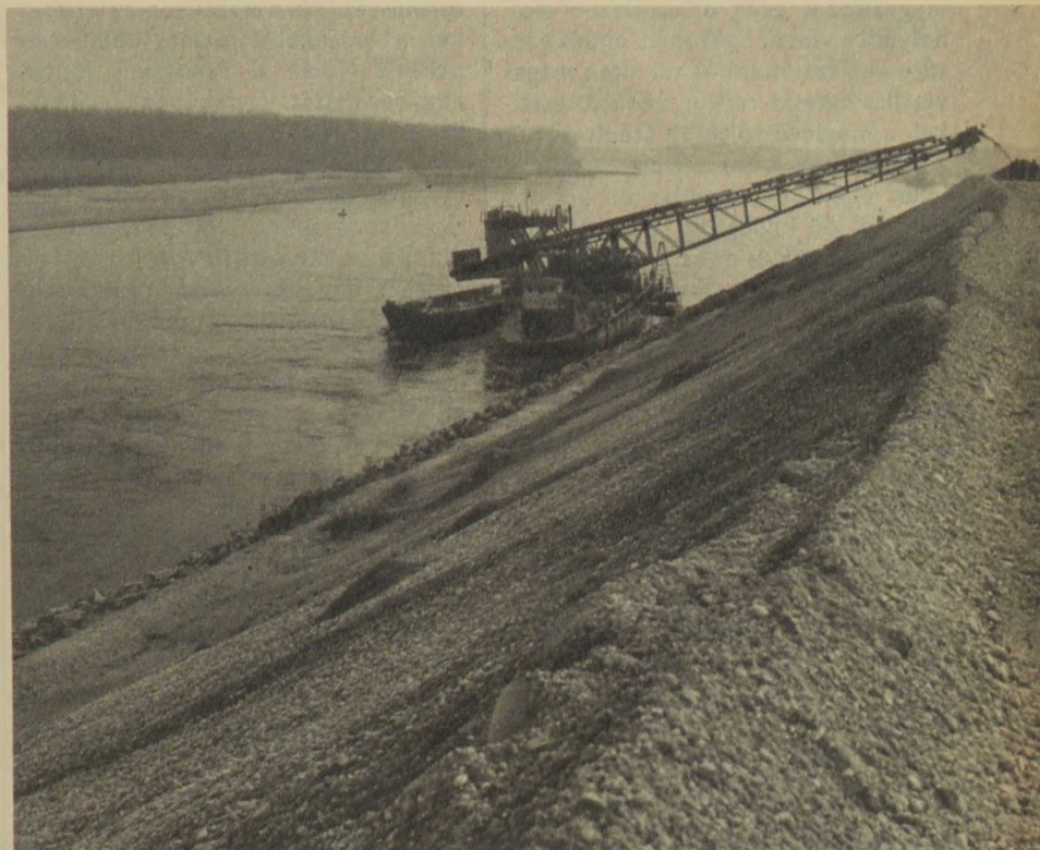
Már megkezdődtek az előmunkálatok: mederkotrás a Szigetközben... (VÍZDOK fotók)
