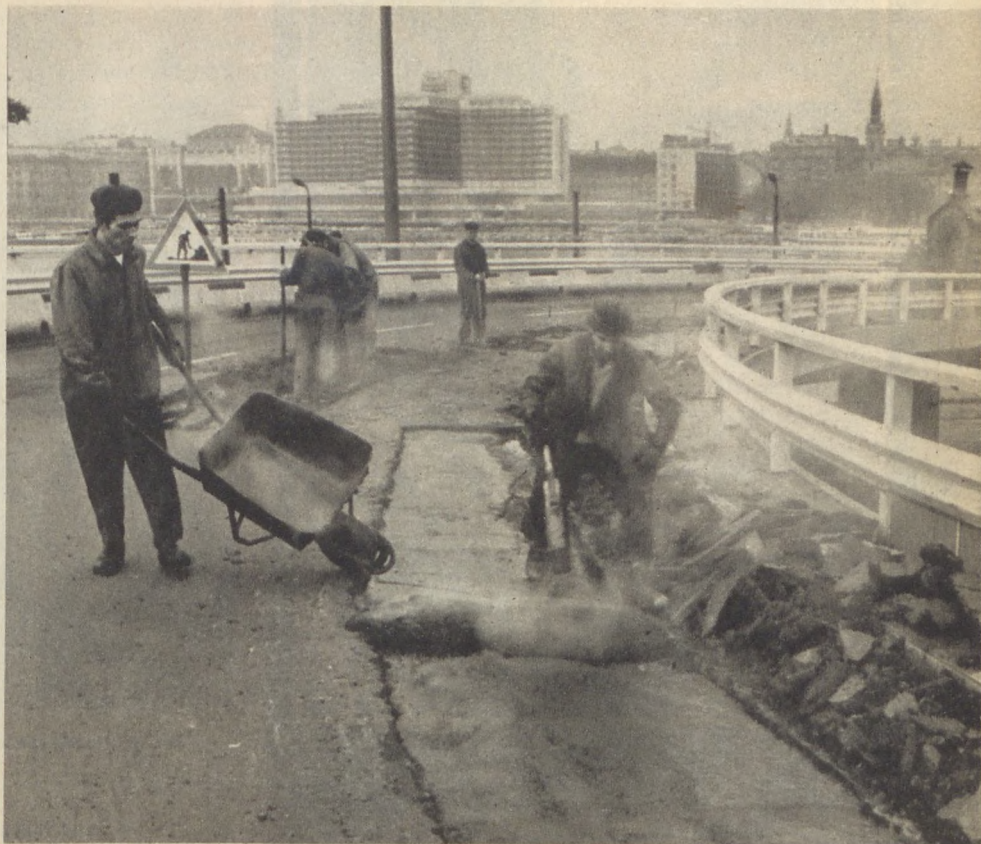
Az aszfaltszőnyeg felújítása során olyan vegyi anyagok kerülnek a levegőbe, amelyek bőrráttalmat okozhatnak. Zárt munkaruhában ennek veszélye jelentősen csökkenthető. (MTI Fotó — Érczi K. Gyula felvétele)
