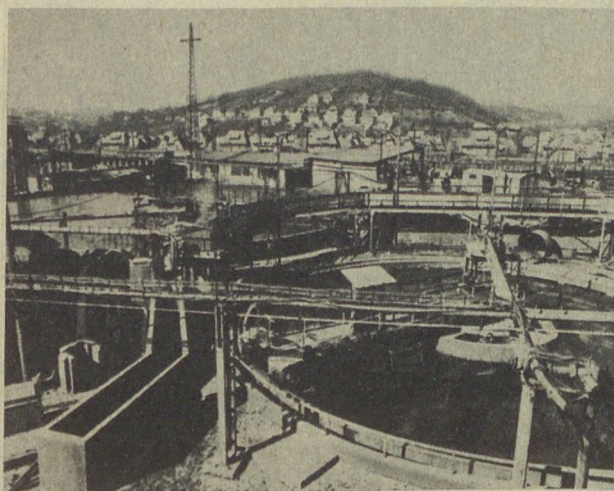
Az Ózdi Kohászati Üzemek területén létesített víztisztító berendezés évente több száz tonna veszélyes hulladéktól menti meg a Sajót
