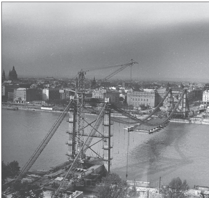
Az egykori Erzsébet híd felújítása – A fotót Chochol Károly készítette (BFL XV.19.g.3.1298)
