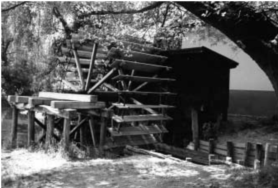
1. kép Patakmalom alulcsapó vízikerékkel, Csallóköz (fotó: FRISNYÁK S.) Photo 1 Mill on a stream with undershot wheel
