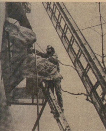
A vasbeton falba ágyazott acélszerkezethez rögzítik a műsziklákát
