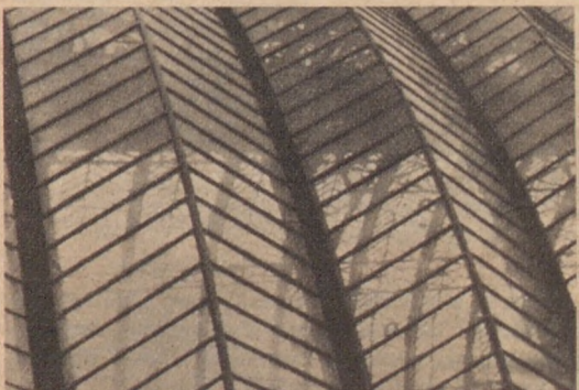
Fent: a levélerezett módosulásból kialakult szilárdító „bordázat” a Victoria amazonica levelének fonákján Lent: a londoni Kristálypalota ugyanezen elv alapján Joseph Paxton által 1850-ben megszerkesztett kupolájának részlete
