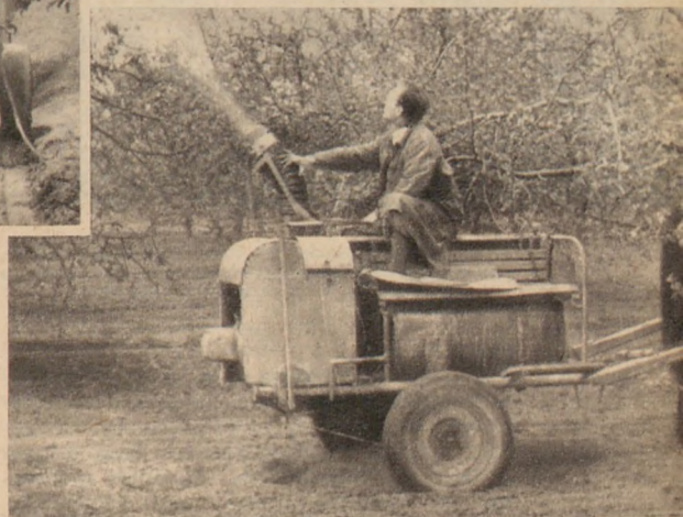
A „Rapitox 1” atomizáló permetezőgép által létrehozott permetkód a levelek fonákját is átnedvesíti
