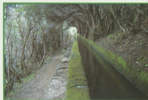
A szigetet behálózó felszíni vízvezető csatorna
