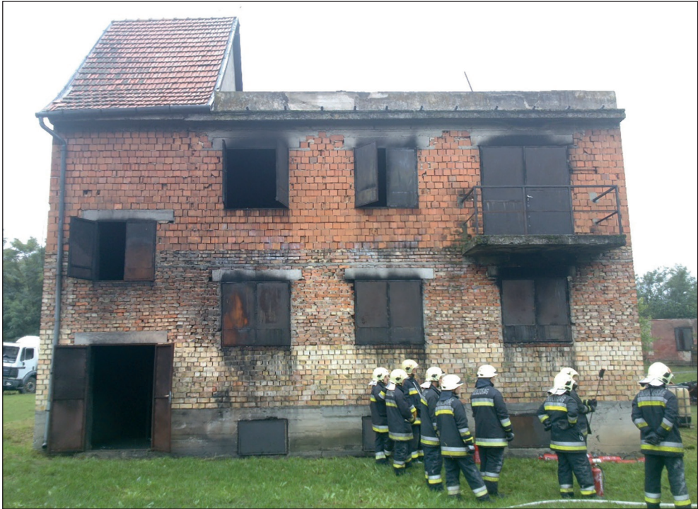
2. ábra: A Katasztrófavédelmi Oktatási Központ téglafalazatú kiképzőépülete, 2013 (Forrás: szerző)
