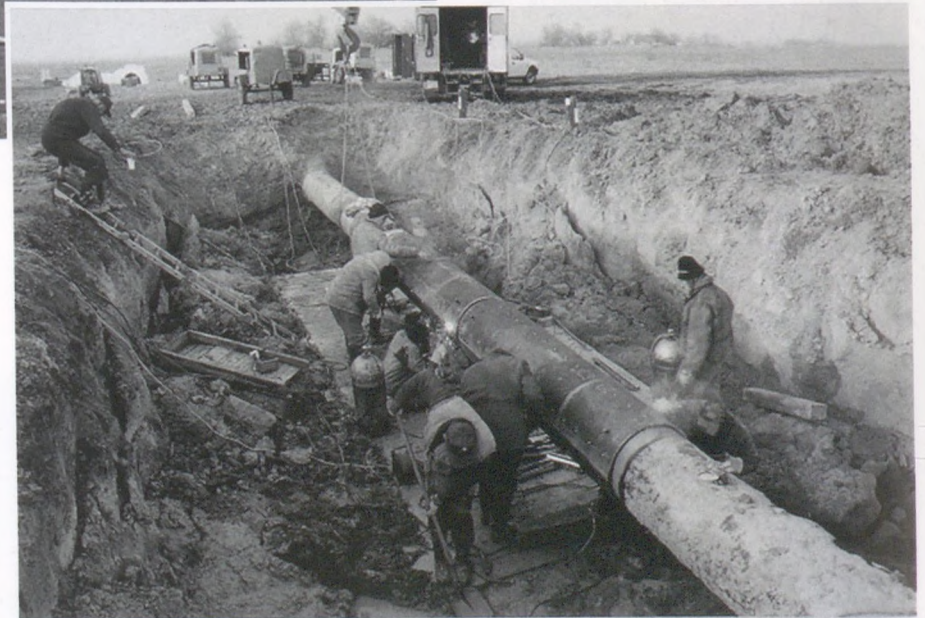
Csővezeték rehabilitáció
