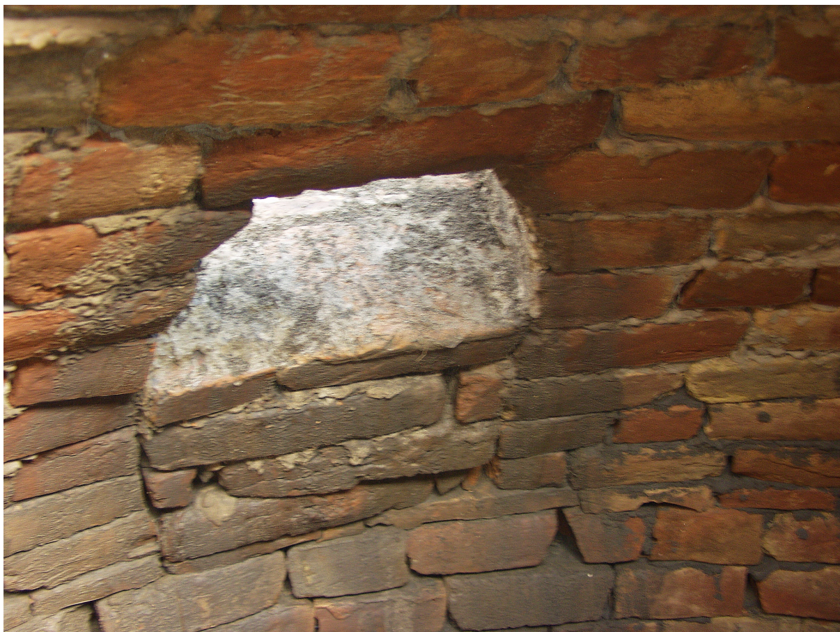
11. kép: A téglaboltozat felé vezető nyílás belső kiképzése a kút belsejéből: megfigyelhető a kútfal tégláinak fekete (sárral) és a boltozat tégláinak fehér (malterrel történt) ragasztása
