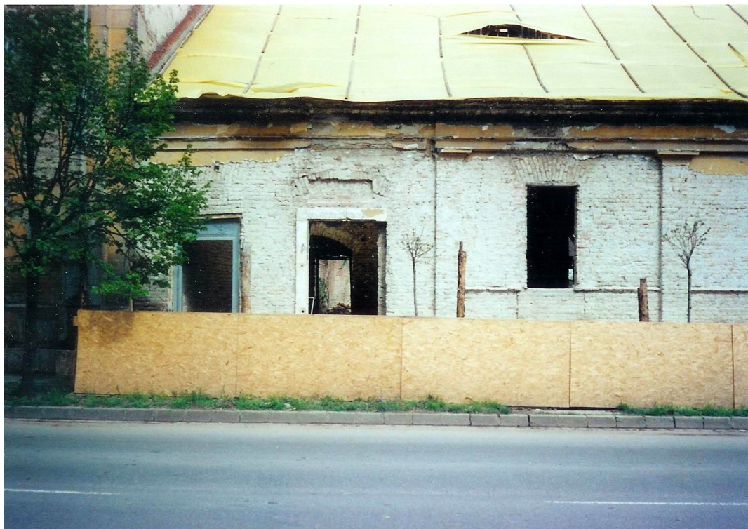
4. kép: A Gólyás-ház felújítás alatt, 2006 áprilisában (Bede András felvétele)
