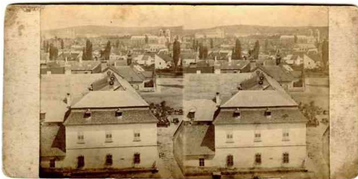
10. A görög katólikus püspöki lak a Közép utca sarkán — az előtői beli nagy épület jó viszonyítási pont a termélység létrejöttéhez
