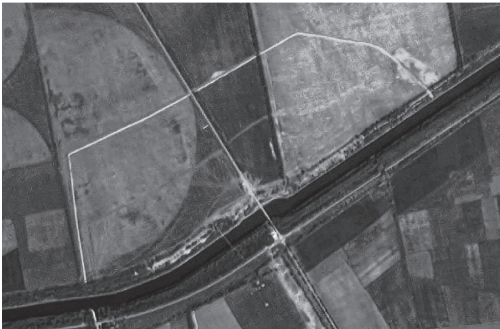
8. ábra Fontos útszakasz és hid erősítése
