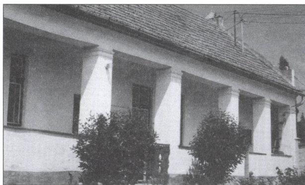
14. kép. Nagygazdaház téglapilléres tornáca. Árpád u. 8. (Pataky Emőke felv., 1995)
