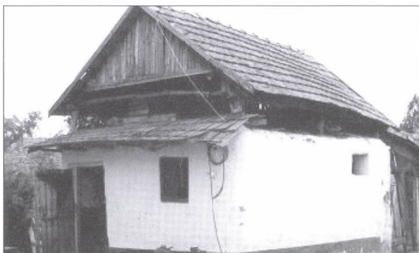
23. kép. Félíg zárt, félíg nyitott szín. A tapasztott falvég fölött ereszes vízvető. Petőfi u. 109. (Pataky Emőke felv., 1995)
