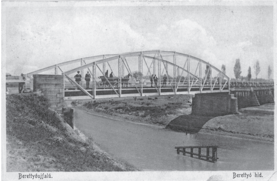
6. kép. Berettyóújfalú, Berettyó-híd
