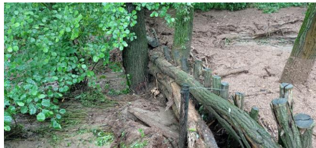
11. ábra. Egy rönkgát által csapdázott hordalék (talaj), Püspökszilágy (Fotó: Halupka 2023. június)
