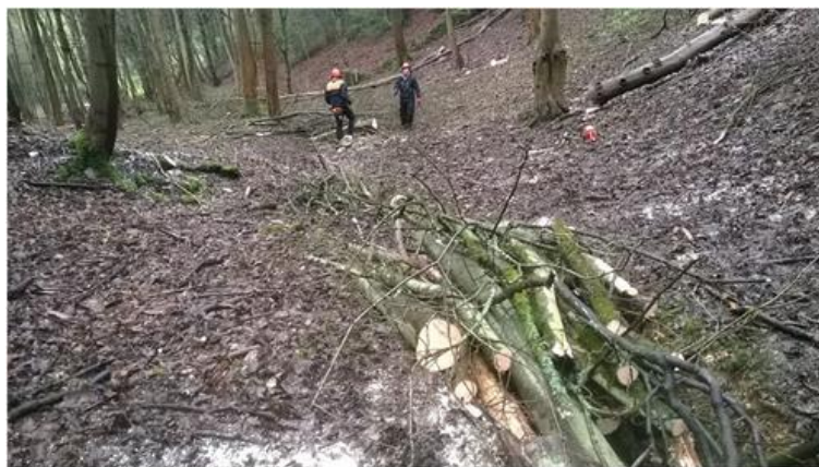
4. ábra. Felszíni lefolyás-lassító ág- és rönköktelek a Frome vízgyűjtőjén, Anglia (Short és társai 2018) Figure 4. Surface run-off attenuation bunds ('gully stuffing') in the Frome catchment, England (Short et al. 2018)
