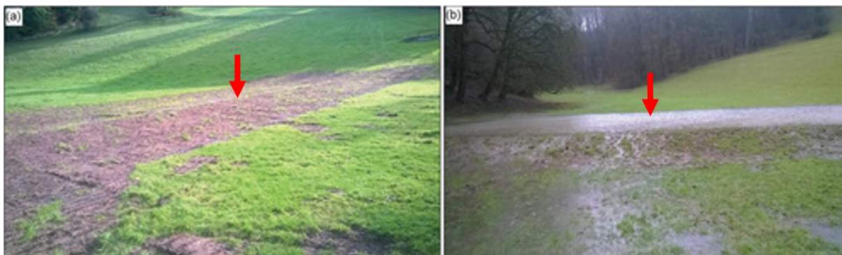
6. ábra. Különböző helyszíneken alkalmazott vízviszatarító földsáncok (piros nyíllal jelölve) a Frome vízgyűjtőjén, Anglia (Short és társai 2018) Figure 6. Water retention earth banks ('earth bunds', marked with red arrows) at various location in the Frome catchment, England (Short et al. 2018)
