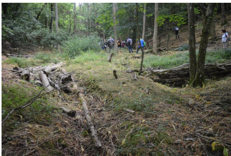
5. ábra. Egy, a számos felszíni lefolyás-lassító beavatkozás (ágkötegek és rönkök) közül, a Frome vízgyűjtője egy völgyében, Anglia (Fotó: Halupka 2022)
