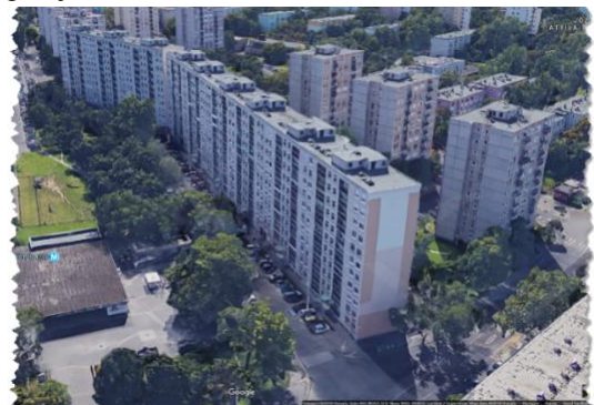
11. ábra. 10 emeletes épületek egy budapesti lakóparkban
