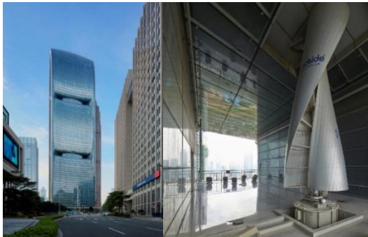
9. ábra. Pearl River torony és a benne lévő szélturbina [22, 23]
