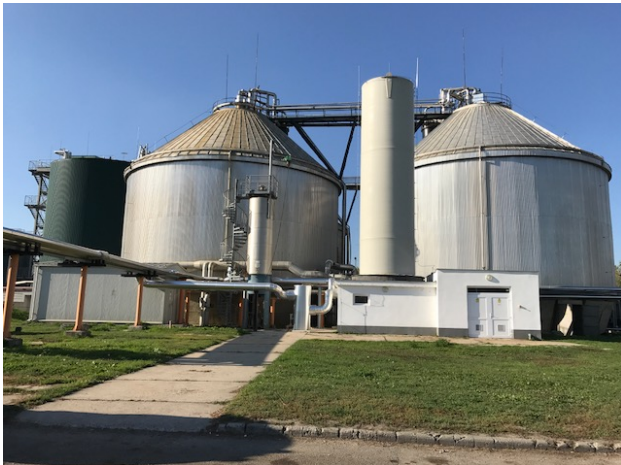
4. ábra Dél-Pesti Szennyvíztisztító telep, fermentorok [10]
