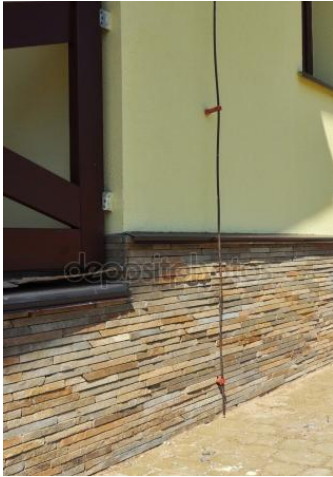
1. sz. kép: Villámhárító konzolos felfogással [10]
