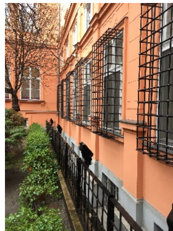
3.sz. kép: Rács földszinti ablakokon Forrás: saját kép
