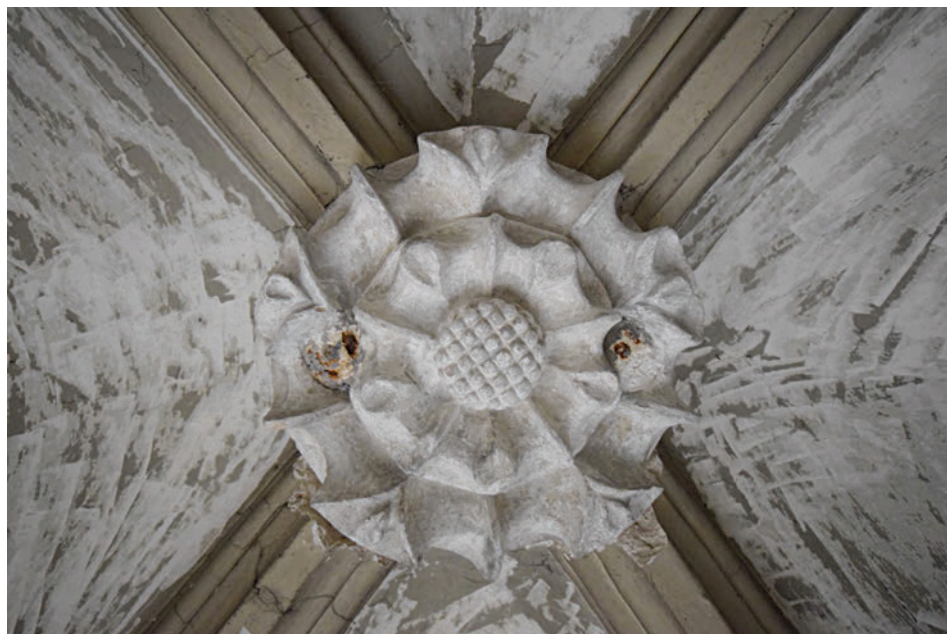
4. A déli mellékszentély boltozatának nyugati záróköve
