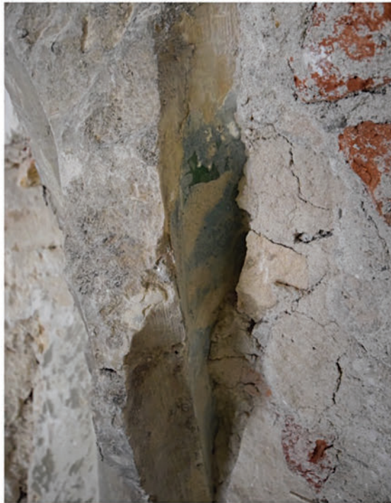
7. Fent: Déli mellékszentély, fejezet fölötti vonóvas a levakolt és zöldre festett, visszafaragott homlokívindításokkal. Lent: Déli mellékszentély, északnyugati késő gótikus bordaindítás zöld festéssel, melyre téglával ráfalaztak
