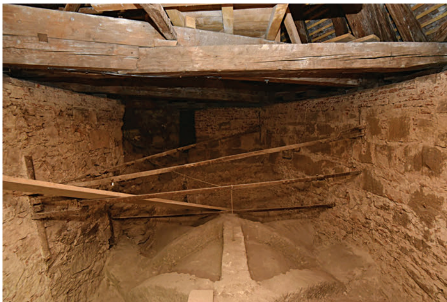
6. A déli mellékszentély boltháta, a koronafal és a gádorfal közti vonóvasak. Balra, középen a csigalépcső kijárata
