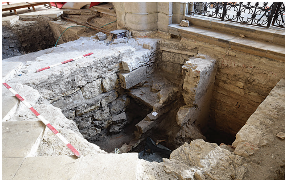
13. A déli diadalív pillér körüli alapozás és annak megerősítése
